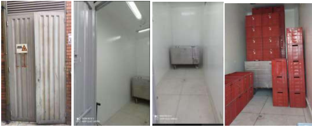
Figura 6. Cuarto de residuos biológicos sede Central
