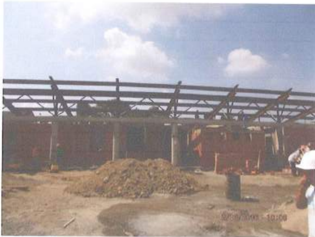
ESTRUCTURA DE CUBIERTA FACHADA POSTERIOR
