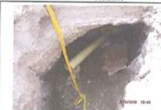
ZONA: CONEXIÓN AGUAS SERVIDAS Y AGUAS LLUVIAS
