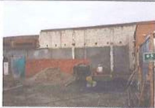
ZONA: MAMPOSTERIA MURO DE CERRAMIENTO
