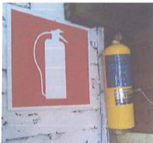
Instalacion de extintores.
