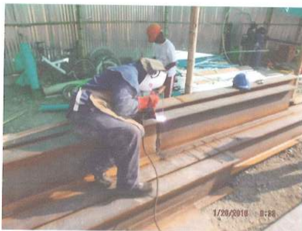
FABRICACION Y ARMADO EN SITU DE ESTRUCTURA METALICA DE CUBIERTA
