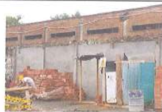
ZONA: MAMPOSTERIA MURO DE CERRAMIENTO
