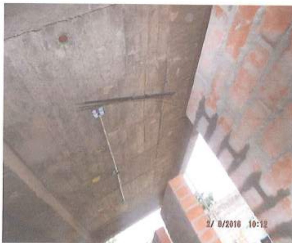
COLOCACIÓN DUCTO ELECTRICO EMT EN LOSA
