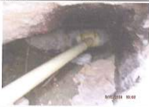
ZONA: CONEXIÓN AGUAS SERVIDAS Y AGUAS LLUVIAS
