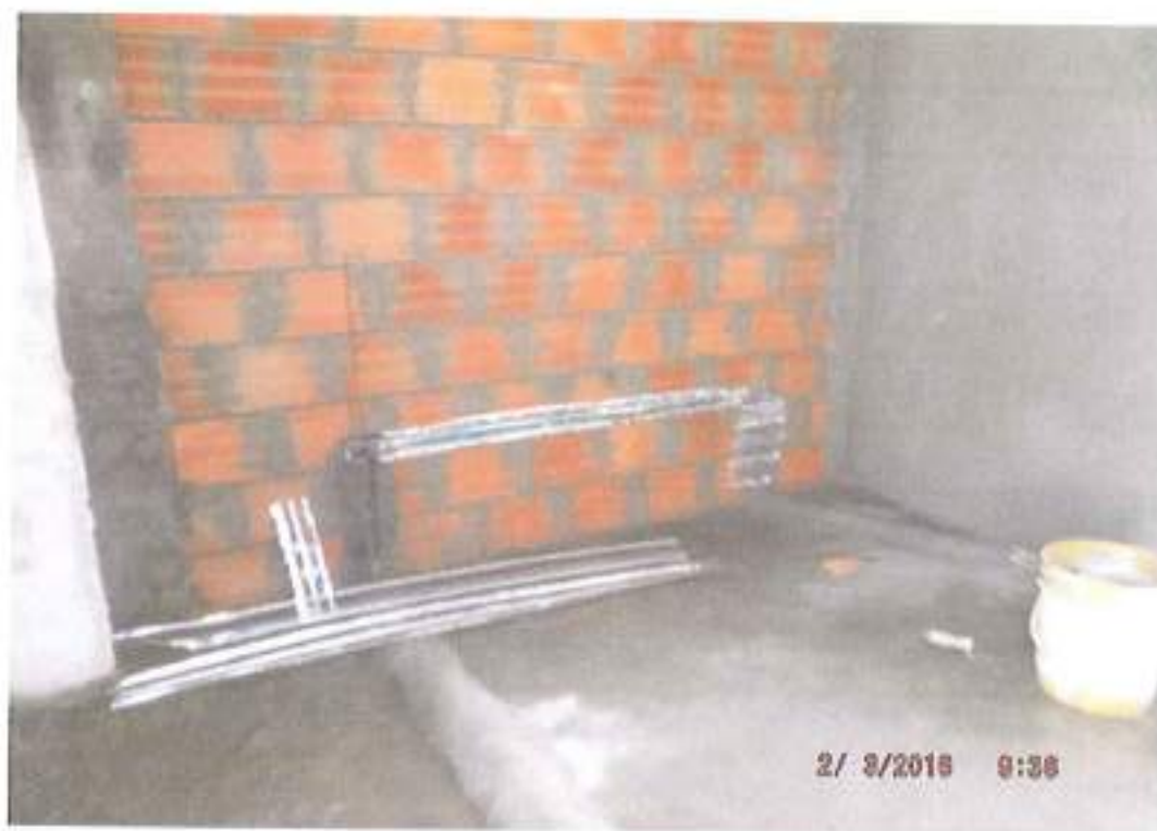
MALLA CON VENA SOBRE DUCTOS ANTES DEL PAÑETE
