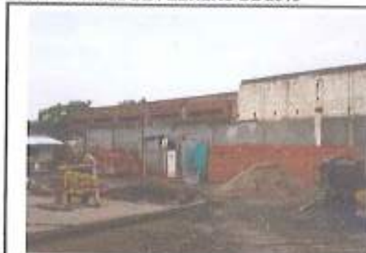
ZONA: MAMPOSTERIA MURO DE CERRAMIENTO
