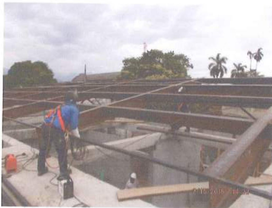
INSTALACIÓN DE ESTRUCTURA DE CUBIERTA
