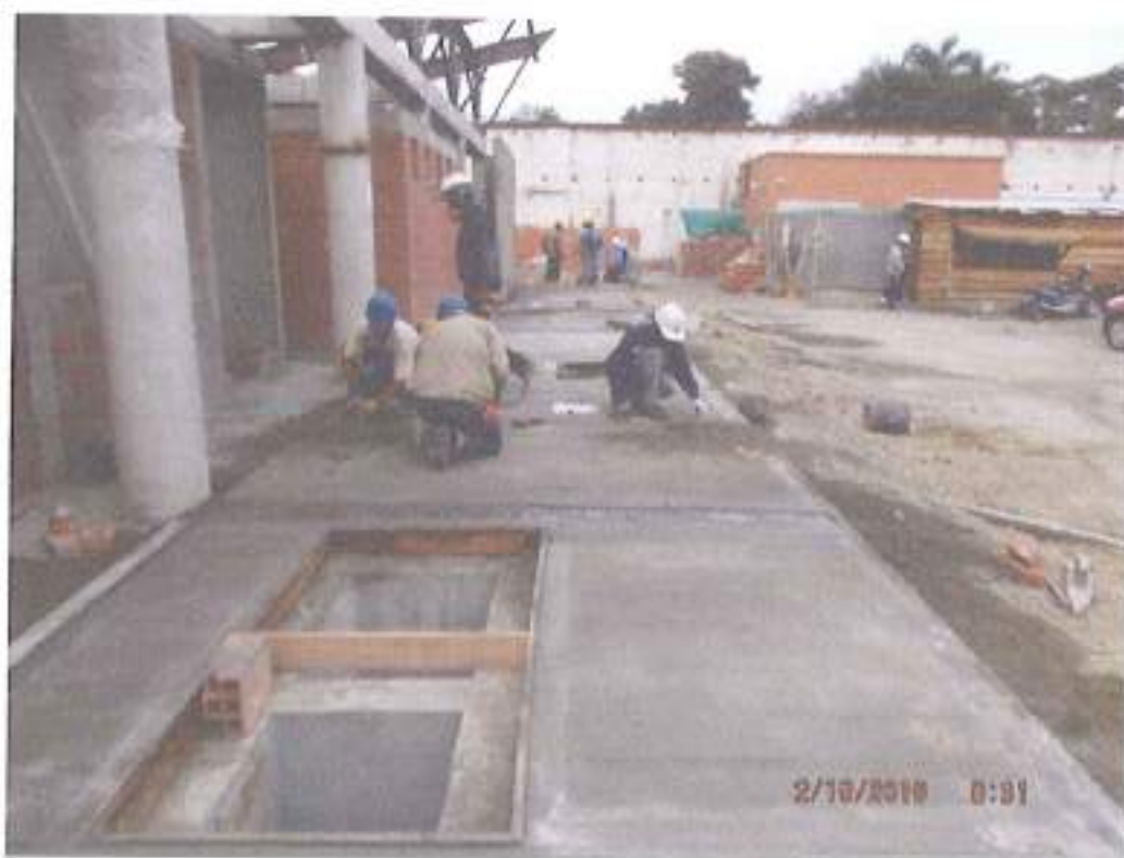
FUNDICIÓN DE ANDÉN – FACHADA POSTERIOR
