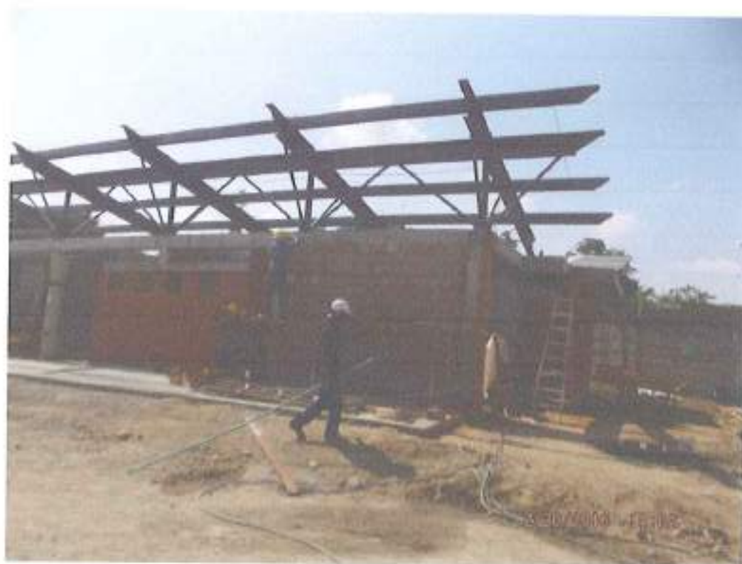
ESTRUCTURA METALICA DE CUBIERTA
