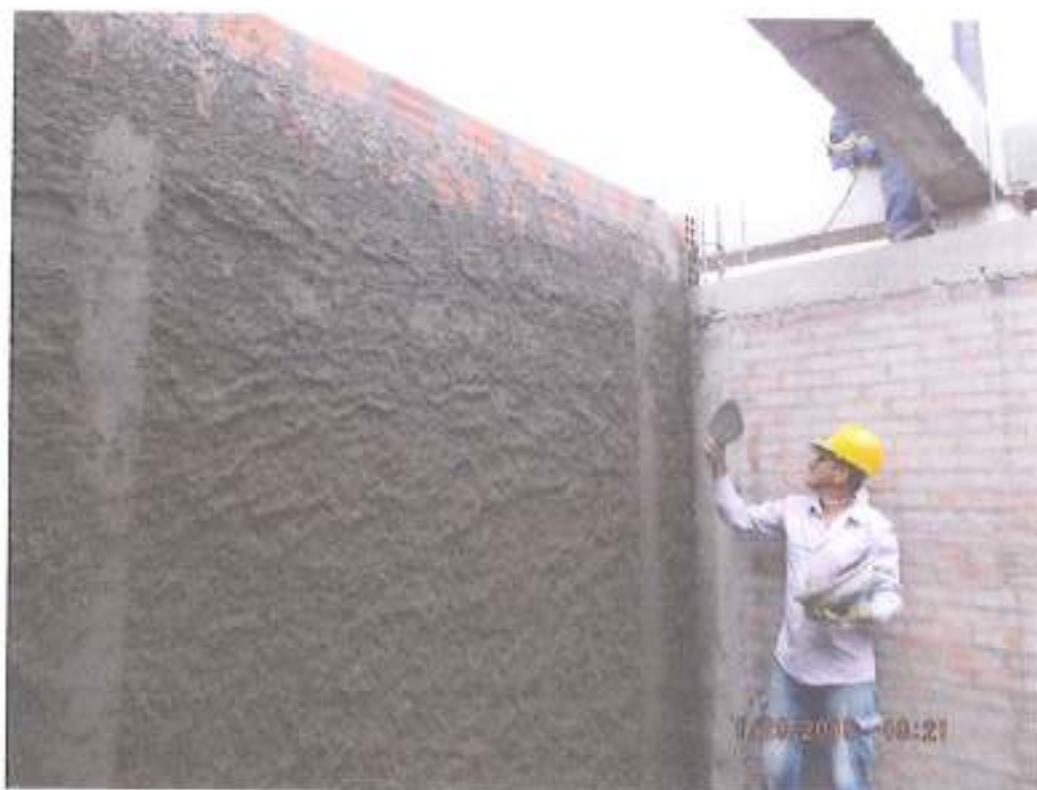
PAÑETES INTERIOR MUROS
