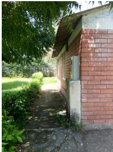
Fachada se realizó mantenimiento ladrillo a la vista y mantenimiento de carpintería metálica
