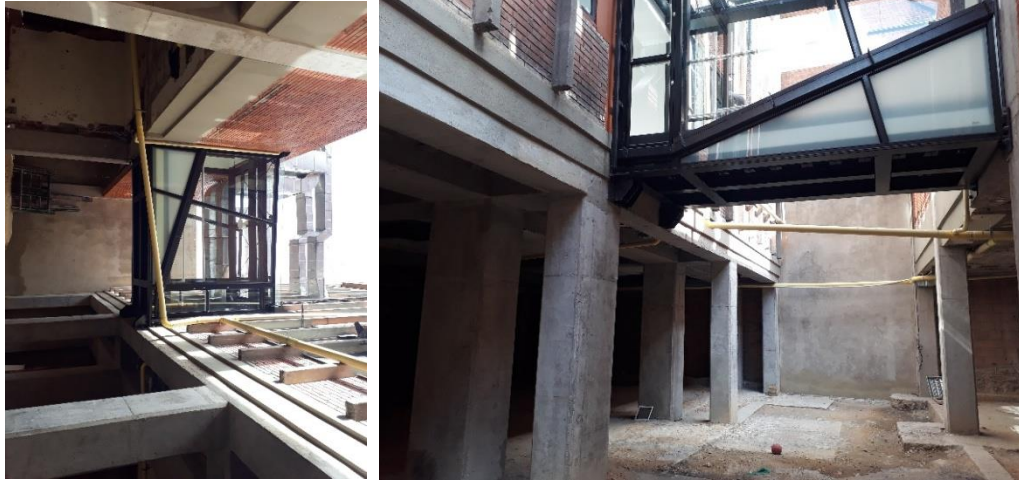
Vista reforzamiento primer piso y puente
