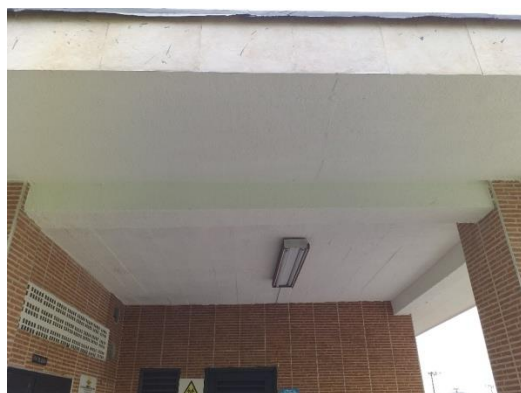
Mantenimiento pintura y red eléctrica exteriores
