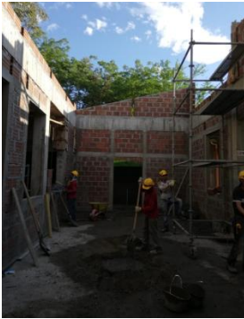
Ejecución de obra parte interna
