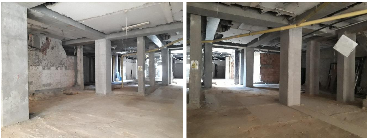
Columnas reforzamiento primer piso
