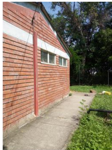
Fachada se realizó mantenimiento ladrillo a la vista y mantenimiento de carpintería metálica
