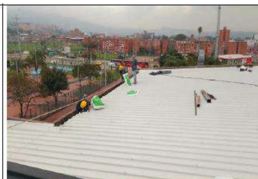
IMPERMEABILIZACION CON BRONCO EN VIGA CANAL ZONA 3
