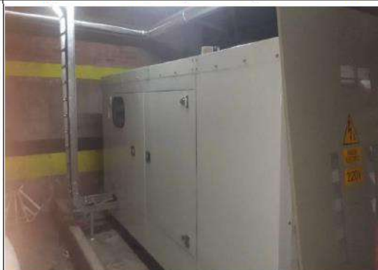
Instalación de cableado entre planta eléctrica y tablero de transferencia del sótano
