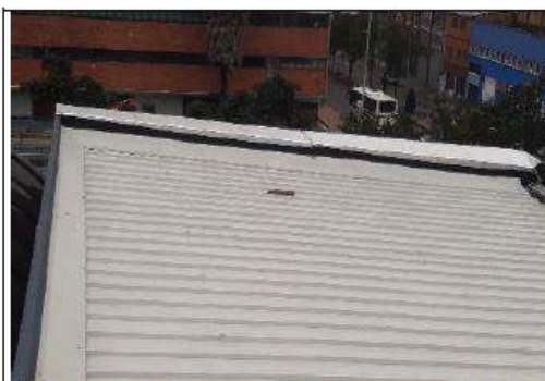
IMPERMEABILIZACION CON MANTO PLACA DE CUBIERTA 3 PISO
