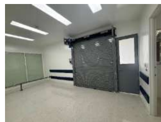
Renovación de acabados vestieres
