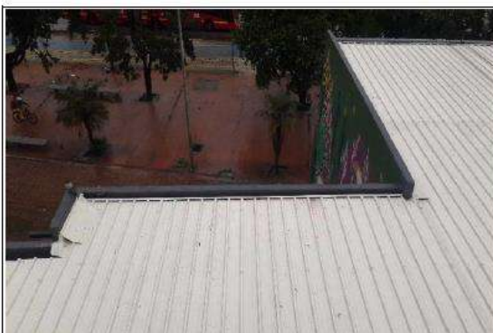
Instalación teja sándwich, remates laterales y frontales e impermeabilización vigas canal y muros externos
