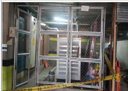
Instalación de estructura metálica y malla eslabonada de planta eléctrica del sótano
