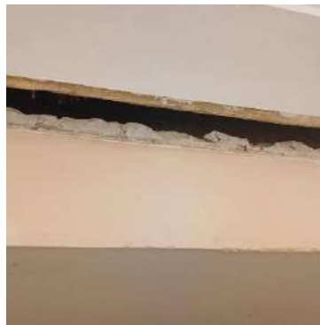
Imagen No 1, 2 y 3 Fuente: Fotografía tomada durante Visita realizada a las instalaciones, fotografías aportadas por experto técnico
